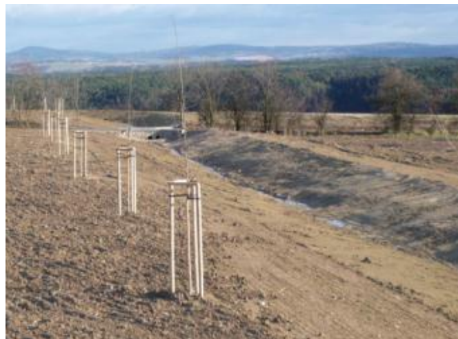
Zasakovací průleh s propustkem
